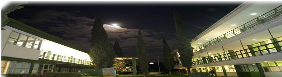
Pasillo que separa al edificio “B”, del edificio “C”, del Plantel
